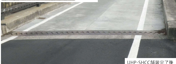
UHP-SHCC舗装完了後
