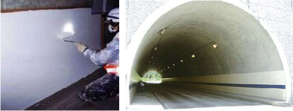
トンネル内装視線誘導塗装仕様・コンクリート保護仕様(補修)
