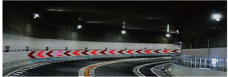
トンネル内装視線誘導塗装仕様・コンクリート保護仕様(補修)
