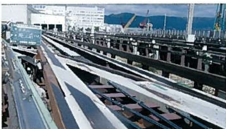
神戸新交通ポートアイランド線 施工前
