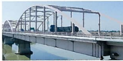
刀水橋 施工後
