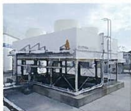
JAXA (宇宙航空研究開発機構) EBC 空気熱交換器架台 施工前
