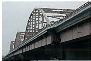
刀水橋(利根川にかかる橋) 施工前
