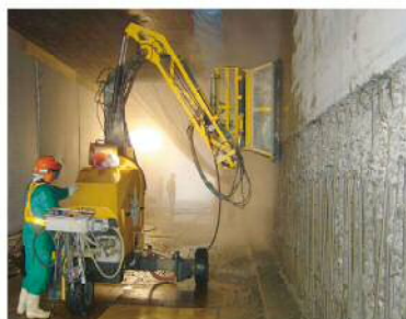
ロボットによるはつり
