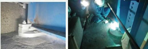
厳しい環境下においても防食性に優れたアルミニウム・マグネシウム金属溶射により鋼材の防錆を行う工法です。一般塗装に比べ、鋼材部の耐久性を向上させます。
