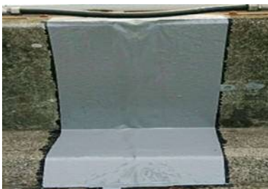
橋梁の壁高欄・地覆部
