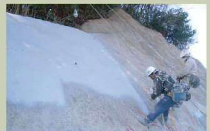
⑦ 靱性モルタルライニング
