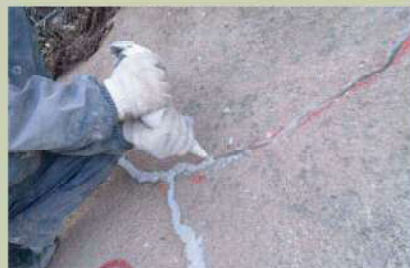
⑤ ひび割れ充填工
