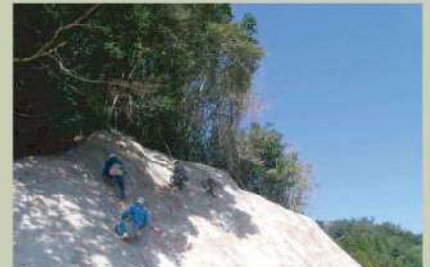
⑤ ひび割れカット・充填工
