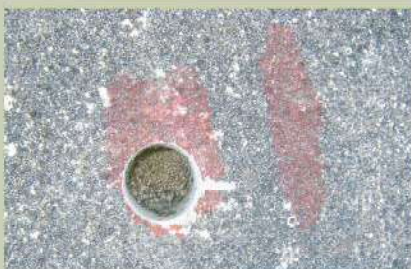
② 調査工（空洞調査）
