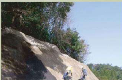
③ 下地処理工（洗浄・目粗し）
