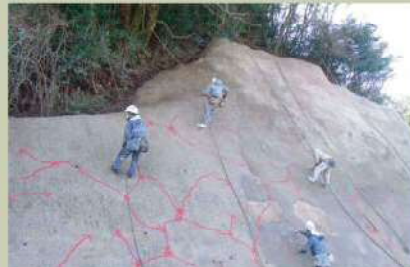
④ ひび割れマーキング・測定工
