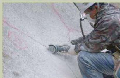
⑤ ひび割れカット
