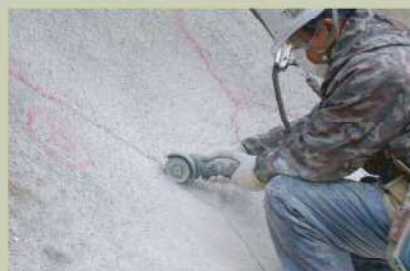
⑤ ひび割れカット
