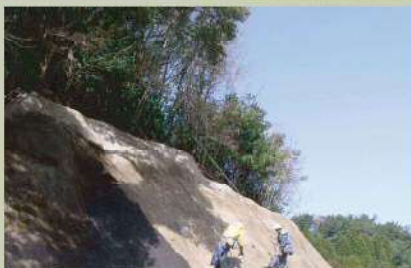
③ 下地処理工（洗浄・目粗し）
