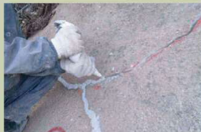
⑤ ひび割れ充填工
