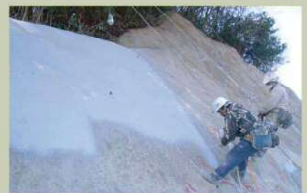
⑦ 靱性モルタルライニング
