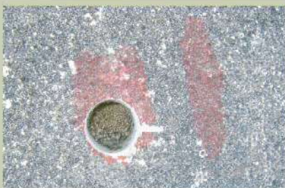
② 調査工（空洞調査）
