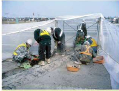
2. 既設ジョイント撤去
