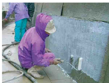
被膜養生材塗布・コテ均し
