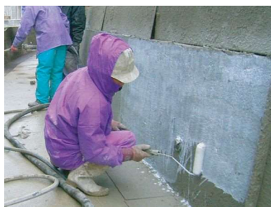
被膜養生材塗布・コテ均し
