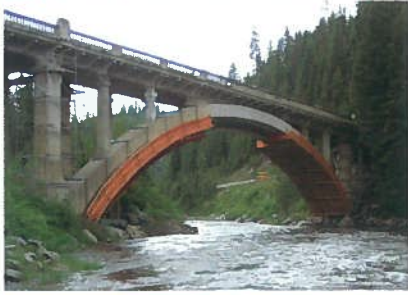
融雪剤を散布する山間部の橋梁
