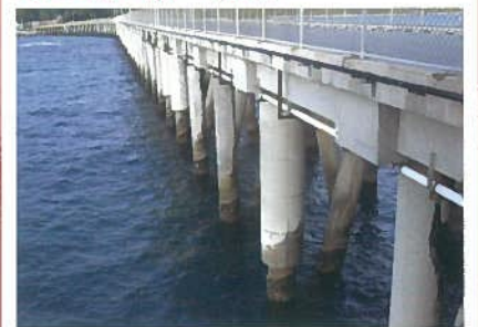
海洋構造物・栈橋
