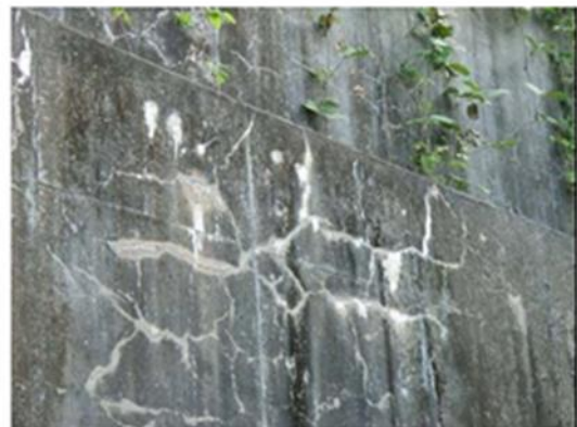
【編み目状のひび割れ】
