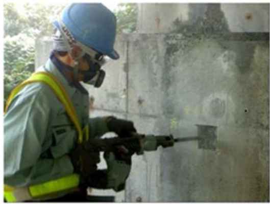
【はつり調査状況】
