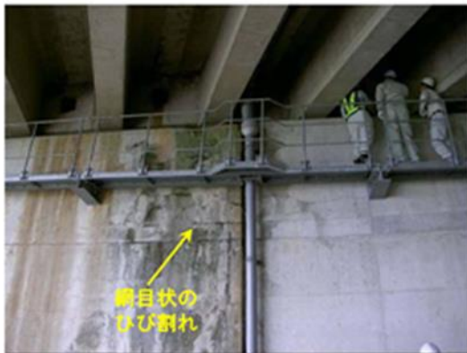
【編み目状のひび割れ】
