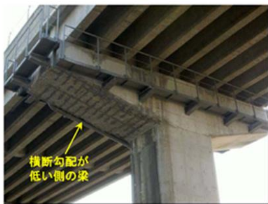
【横断勾配の低い側の梁部で劣化が顕在化】
