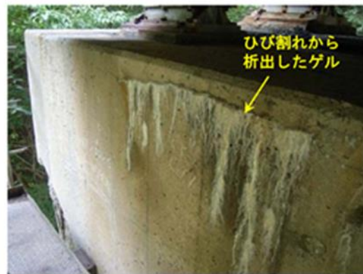
【ひび割れから析出した ASR ゲル】
