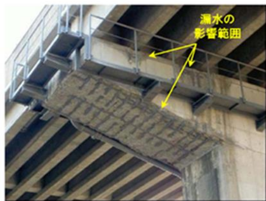
【横断勾配の低い側の梁部で劣化が顕在化】
