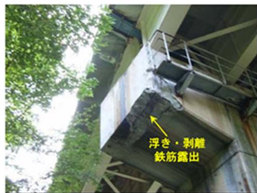
【漏水の影響範囲で浮き・剥離、腐食鉄筋の露出】
