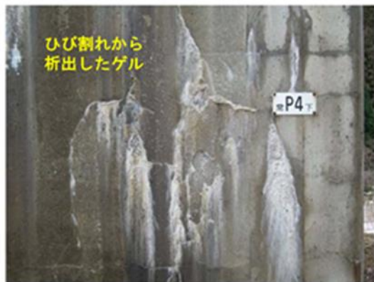
【ひび割れから析出した ASR ゲル】
