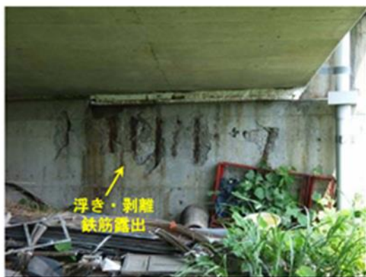
【漏水の影響範囲で浮き・剥離、腐食鉄筋の露出】
