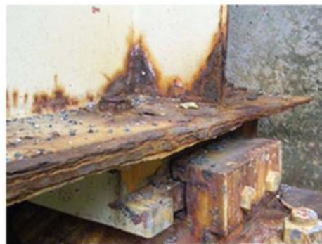
【桁端部の塩害劣化】
