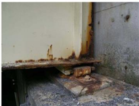
【桁端部の塩害劣化】
