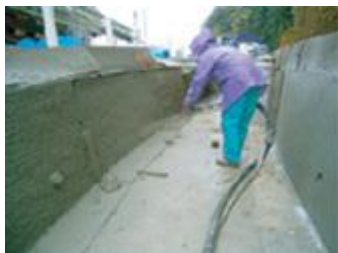
【モルタル吹付け工】
