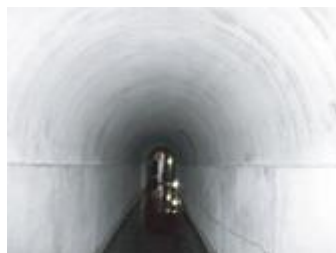
【導水路トンネル】
