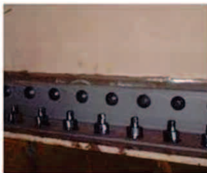
【当て板補強工の施工例】
