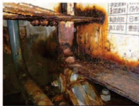
【滞水しやすい下フランジ付近で顕著になった腐食】
