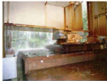
【劣化した伸縮継手からの漏水】
