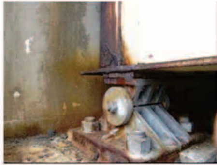
【漏水の影響範囲で桁端部が腐食】
