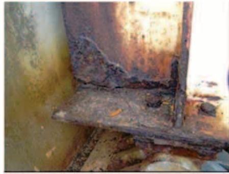
【漏水の影響範囲で桁端部が腐食】
