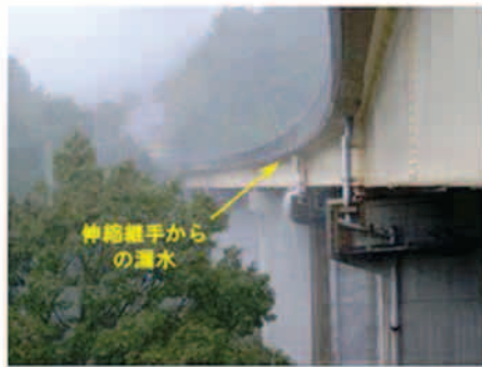
【劣化した伸縮継手からの漏水】
