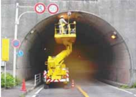
【トンネル覆工調査状況】
