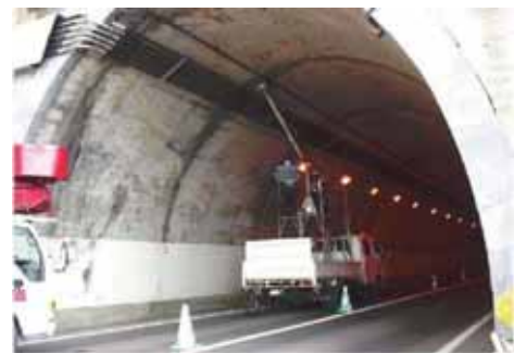
【簡易ボーリング調査の施工状況】
