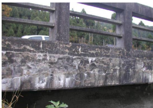
【一般的な路面排水の影響を受ける箇所でのアルカリシリカ反応による劣化事例】
