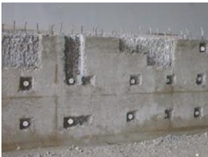
【BOX 擁壁修復】
