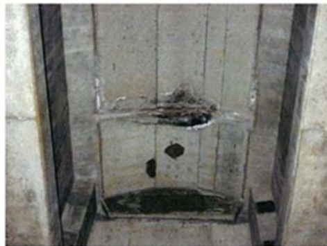
【打継目に沿った漏水の浸透による劣化の例】
