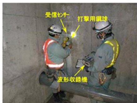
【インパクト法によるグROUT調査(せん断鋼棒)】
