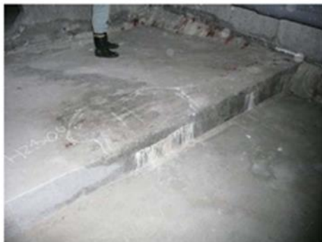
【排水管からの漏水による下床版劣化の例】
