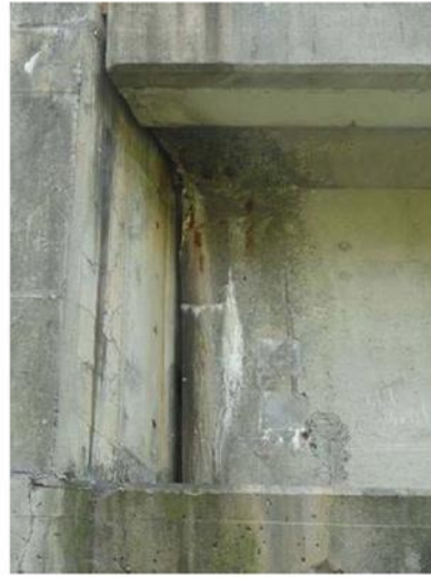
【伸縮継手からの漏水の桁端部への浸透による桁端部劣化の例】
