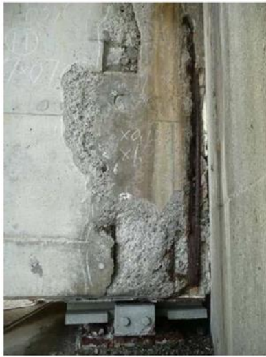
【伸縮継手からの漏水の桁端部への浸透による桁端部劣化の例】
