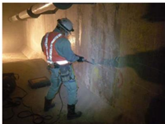
【はつり調査状況】
