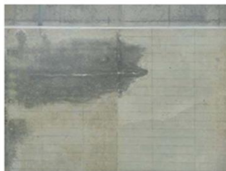
【排水管からの漏水による下床版劣化の例】
