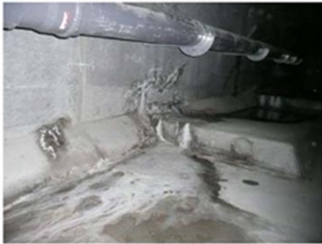
【グラウトホースを伝う漏水の例】
