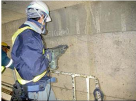
【削孔法による調査(主ケーブル)】
