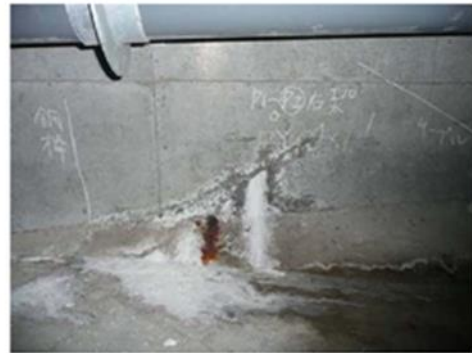
【グラウトホースを伝う漏水の例】
