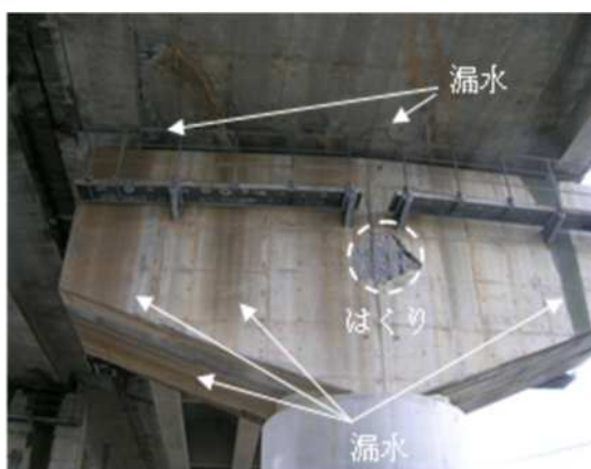
【桁端部の塩害の状況】
