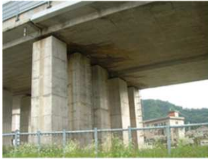
【伸縮装置からの漏水の事例】
