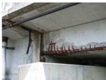
【中空床版側面・下面の浮き・剥離、腐食鉄筋】
