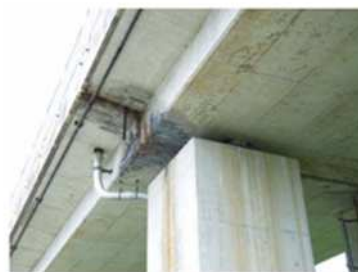
【中空床版側面・下面の浮き・剥離、腐食鉄筋】
