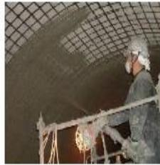
HPFRCCグリッド工法は、鉄筋同等以上の強度特性を有する炭素繊維グリッド筋をHPFRCC（韌性モルタル）で覆うことにより、トンネル内面を補強する工法です、薄肉で内空断面を侵さない補強工法です。
