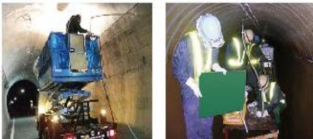
セットフォーム工法は、トンネルの覆工コンクリート背面に生じた空隙を硬質発泡ウレタンによって充填する裏込め注入工法です。短時間で発砲硬化する耐久性に優れたポリウレタンフォームを使用します。
