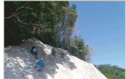
⑤ひび割れカット・充填工
