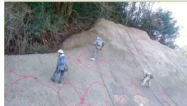
④ひび割れマスクング・測定工
