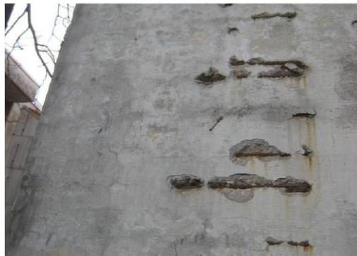
【一般的なかぶりの薄い箇所における中性化による劣化事例】
