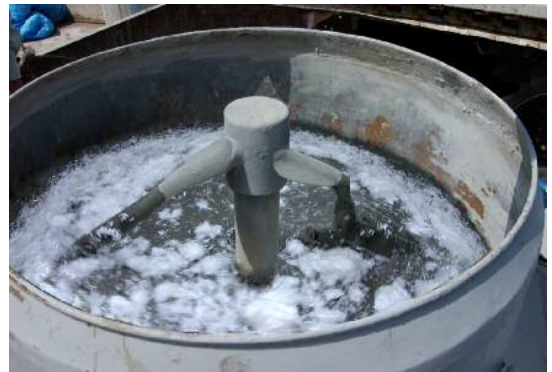
写真-7 充填材の練り混ぜ状況
