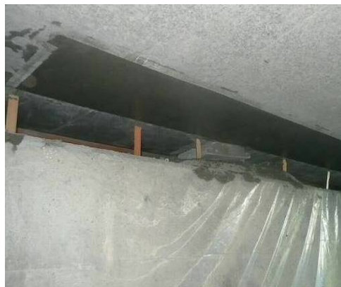
写真-10 断面修復完了状況
