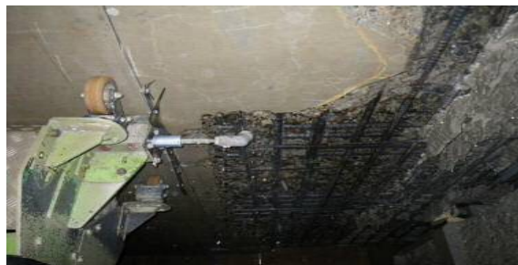
写真-6 はつり状況
