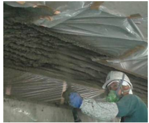
写真-9 吹付け状況
