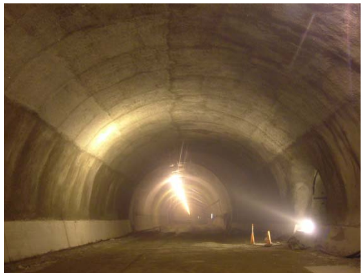
図6 吹付け覆工完了状況
